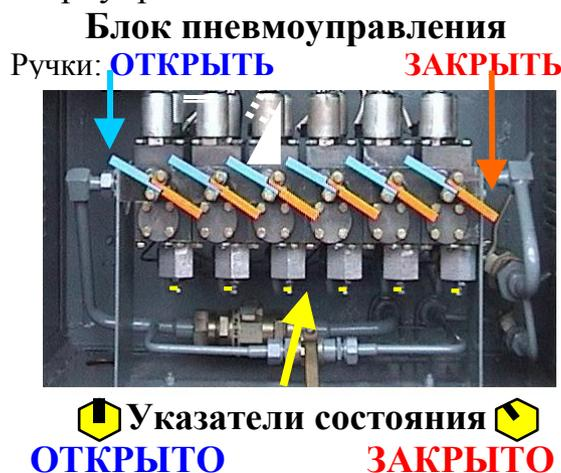
Рис.1. Блок пневмоуправления .
